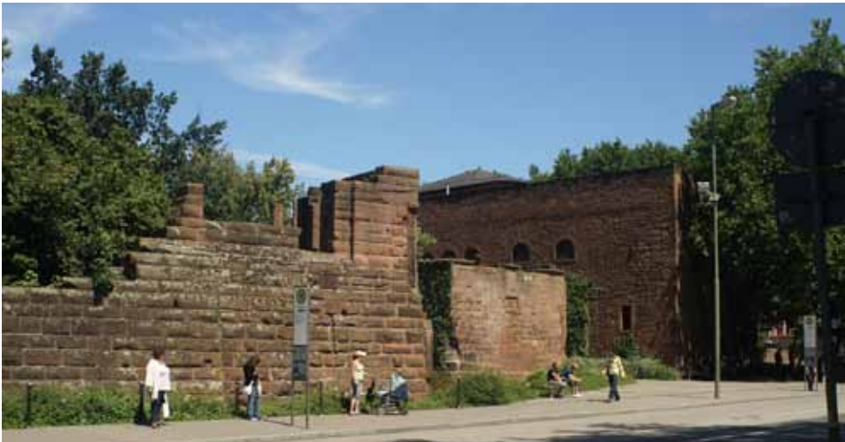
Kaiserslautern, Ruinen der staufischen Pfalz mit dem Saalbau des Pfalzgrafen Johann Casimir im Hintergrund. Links die so genannte Kapellenmauer, in der Bildmitte der Rest des Südflügels Johann Casimirs.
